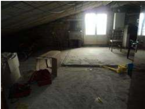
Soffitta al P2 allo stato grezzo sub 7
